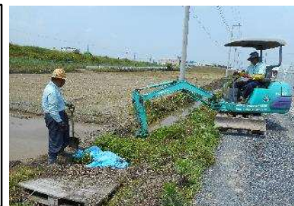
( 水路の泥上げ )
