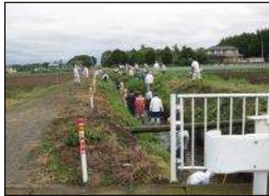
( 水路の草刈り、泥上げ )
