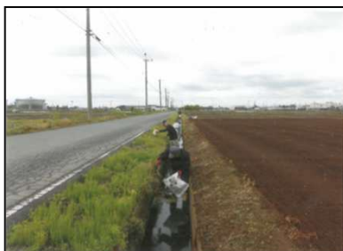
( 水路の泥上げ )
