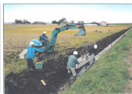
( コンクリート水路への更新 )
