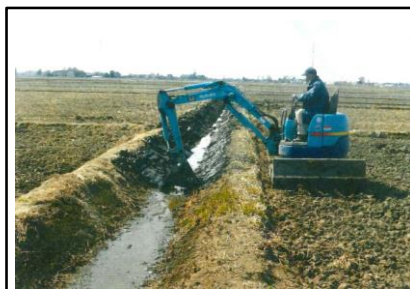
( 水路掘削作業 )
