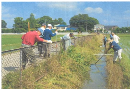
( 水路の泥上げ )
