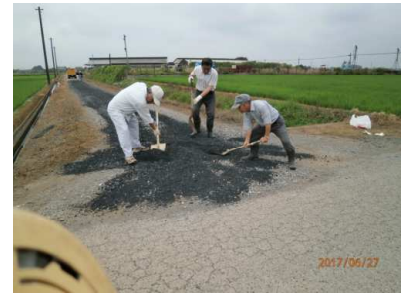
(農道砂利補修)
