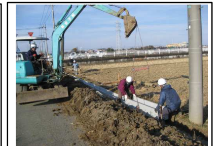
( U字溝布設工事 )
