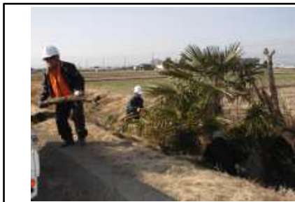
( 水路雑木の伐採 )
