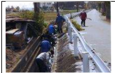
(水路の泥上げ)
