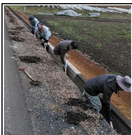
（水路泥さらい状況）
