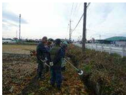
( 排水路の草刈り )
