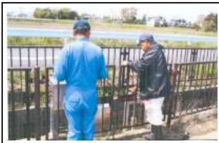
( ゲートの点検 )
