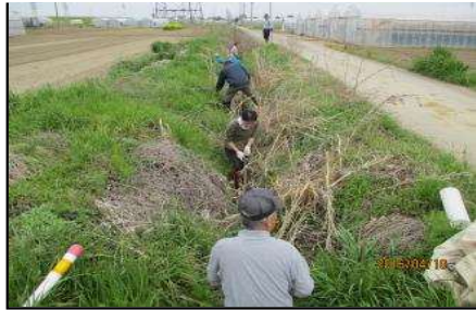
( 水路の泥上げ )
