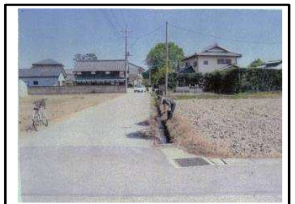
( 水路の泥上げ )
