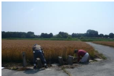
(水路の泥上げ)
